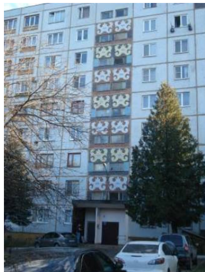
Рис. 5. Орнамент на фасаде жилого дома Fig. 5. Residential building facade ornament
