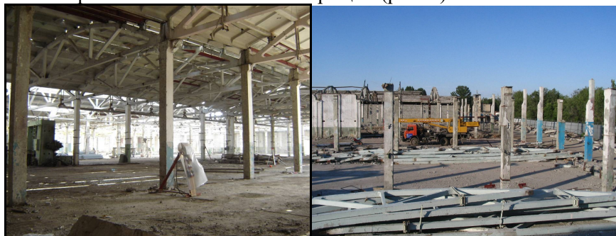
Рис. 3. Внешний вид конструкций цеха до и во время реконструкции Fig. 3. Workshop Structures Surfaces Before and During Reconstruction
