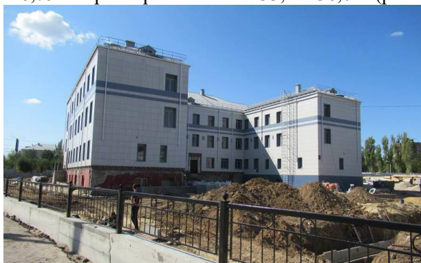
Рис. 1. Общий вид здания Fig. 1. General view of the building
